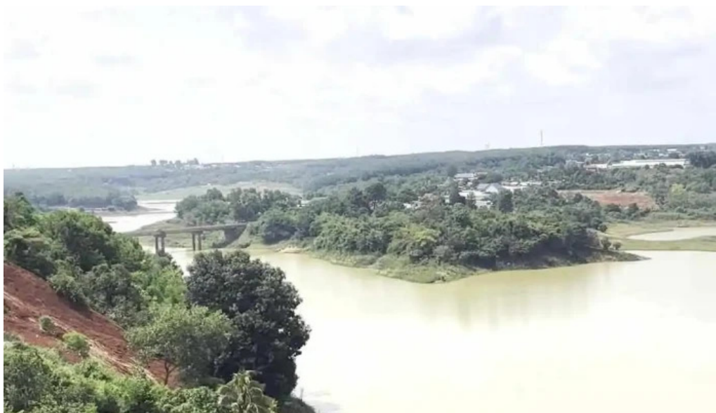
Ho thủy điện thác Mơ hồ chứa nước
